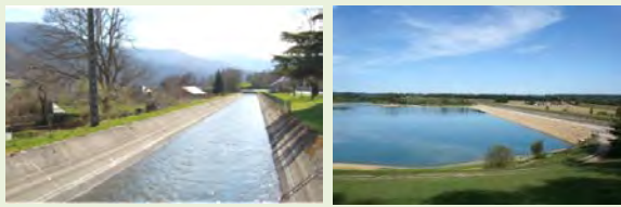
Canal de la Neste et barrage réservoir de la Gimone.
